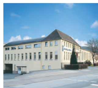
Завод в г. Ауэ располагает производственными площадями более 14 000 м 2
